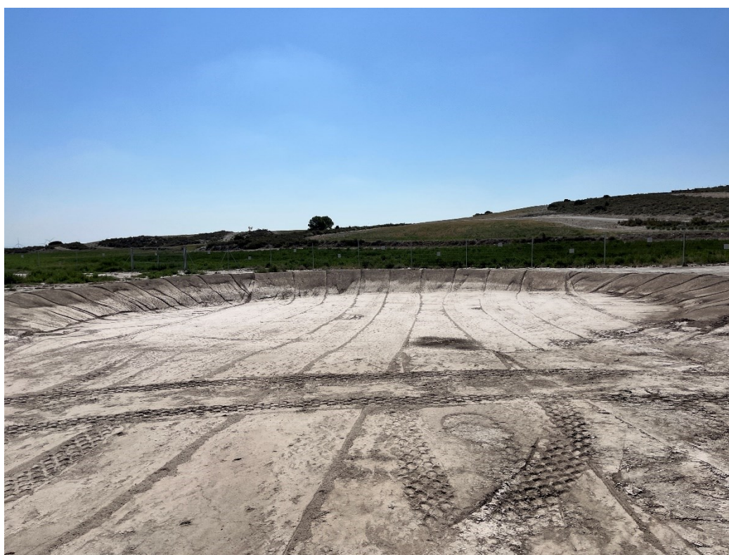
Figura 10 Balsetes para la acumulación de agua de escorrentía
