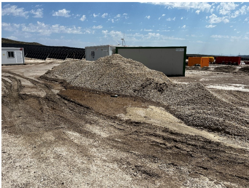
Figura 2 Retirada de la zahorra de la zona de casetas
